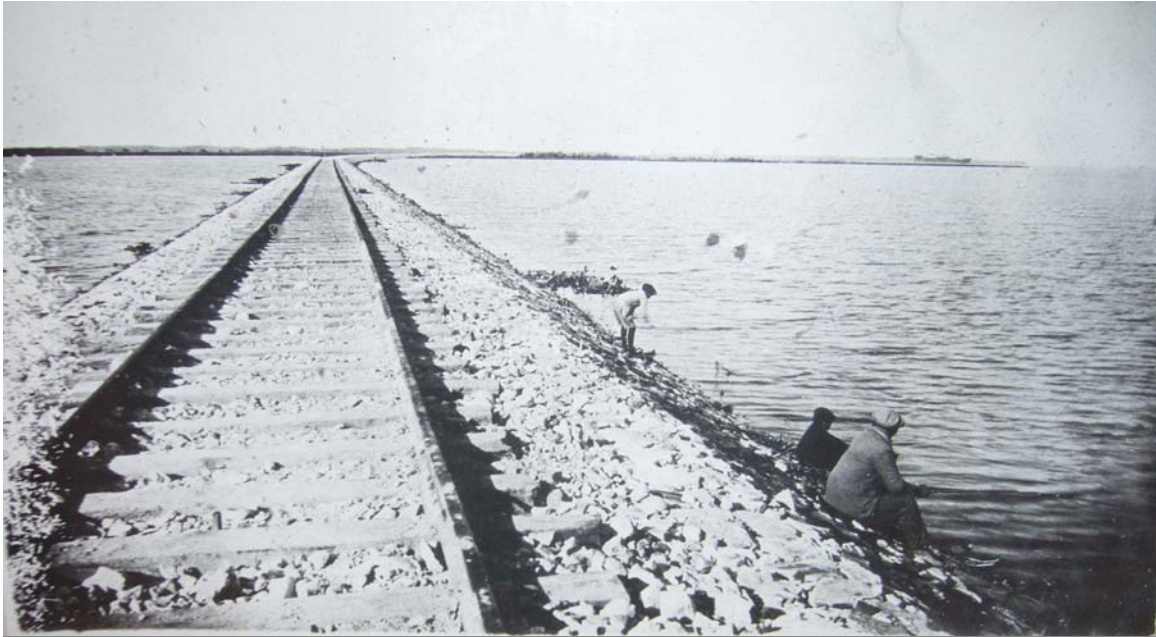
Vista del dique de defensa del puerto construido para evitar su sedimentación
