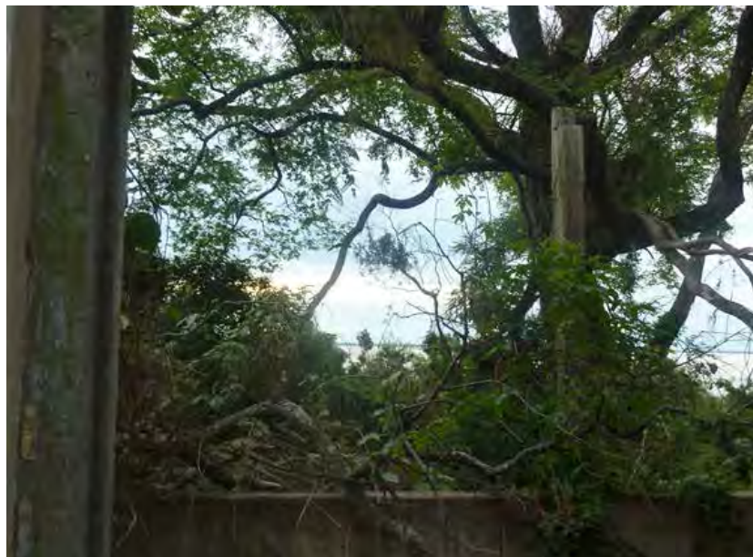
Fig. 17. En la imagen se puede apreciar la invasión de especies exóticas en las construcciones del Barrio chino.
