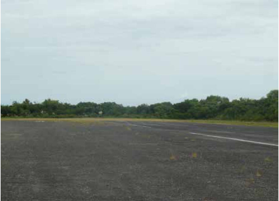
Fig. 24. Zona norte de la pista de aterrizaje, se observa la parte final de la misma.
