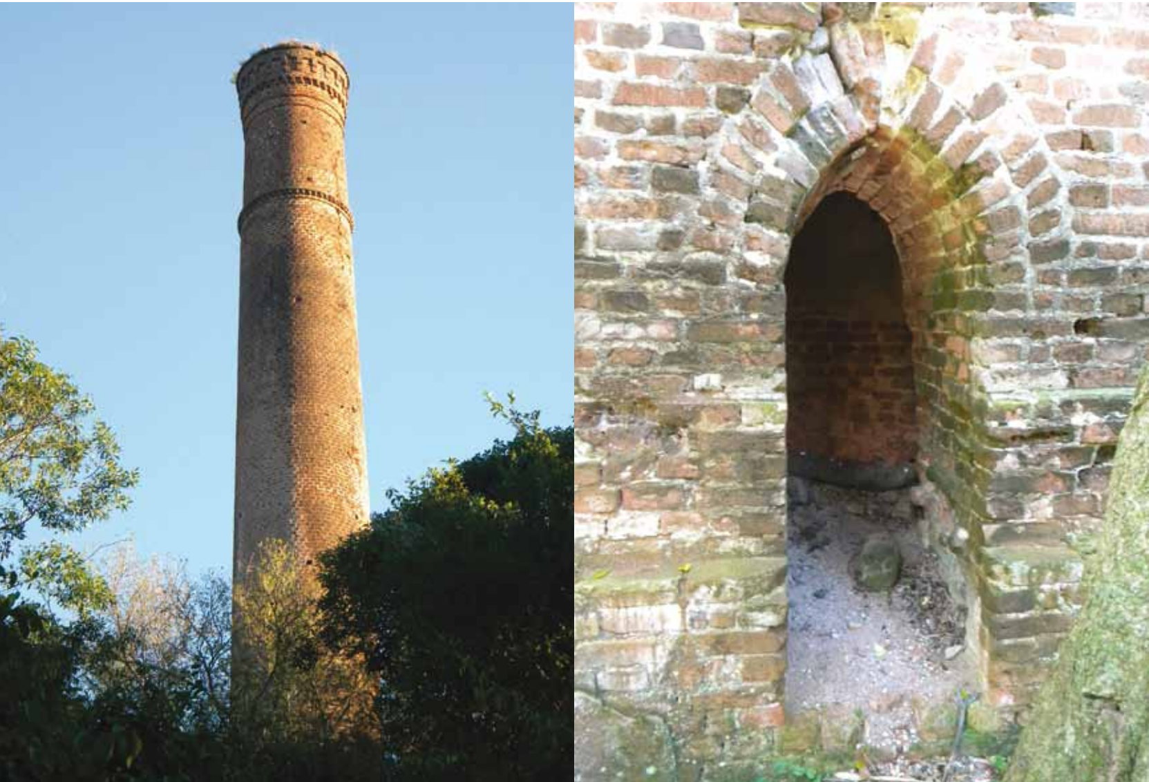
La chimenea del antiguo ingenio San Juan (detalle del remate y de la base).
