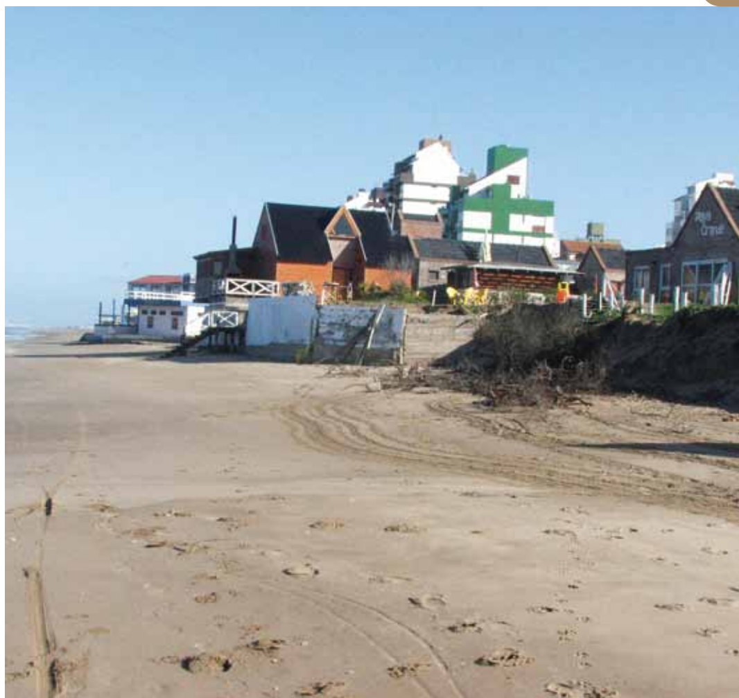
Urbanización sobre el frente costero, eliminación de la duna frontal, reducción de playas por erosión y fallidos muros de contención en San Bernardo (partido de la Costa, año 2005).
