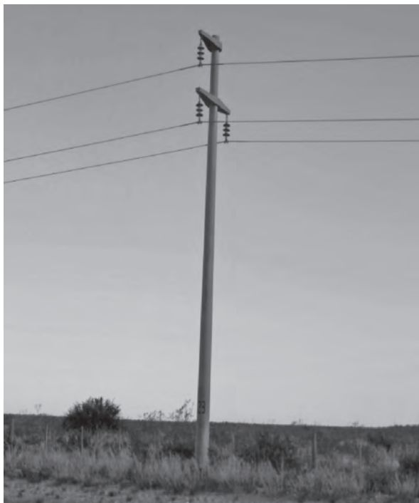
Fotos 5 y 6. Monoposte y poste de retención (biposte) en T4. El tendido de esta transecta se compone de monopostes. En general, cada 6 km se intercalan bipostes de retención, distintos en su estructura, a los bipostes de T1 y T2. En el tipo de monoposte de T4, G. polyosoma no nidifica. Fotos: Eduardo De Lucca.
