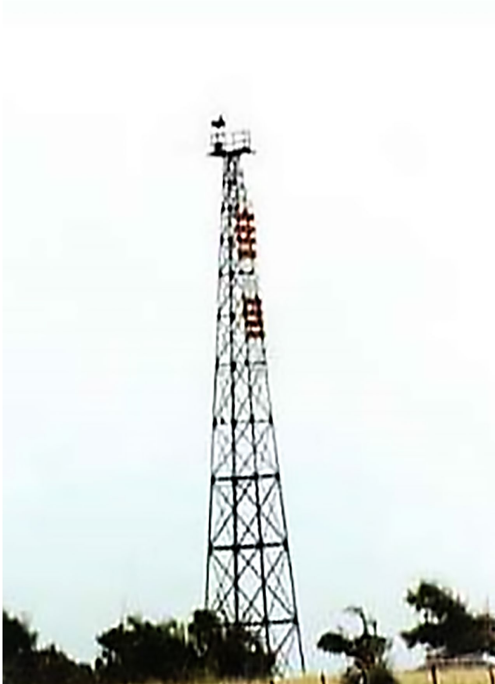
Figura 3: Faro de Punta Piedras. Foto: Gentileza CFH. Niño Seeber (Depto Balizamiento ARA).
