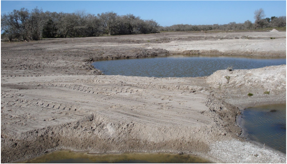
Figura 3. Cantera de extracción de conchilla inmediatamente después del cese de la explotación. Foto: J. Goya.
